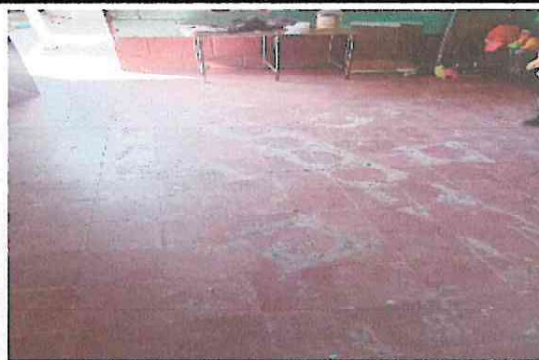
Foto 2: Renglón 6 . Sustrucción de piso de concreto por cerámico (2 salones de clases, dirección y un corredor)
