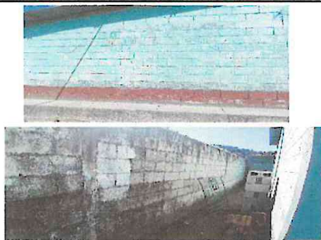
Foto 3: Renglón 9. Pintura en muros interiores y exterior (salones, cocina, sanitarios)
