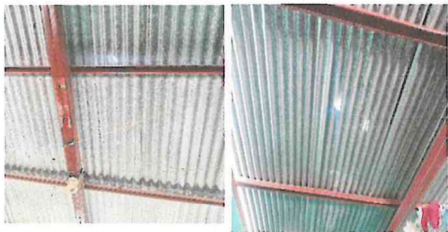
Foto 1: Renglón 1 Sustrucción de lámina acanalada por lámina troquelada.
